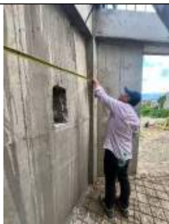
Ilustración 11: 21/05/2025 Verificación dimensiones elementos estructurales
