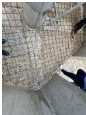
Ilustración 12: 21/05/2025 Malla electrosoldada expuesta, no se funde plaza de entrepiso
