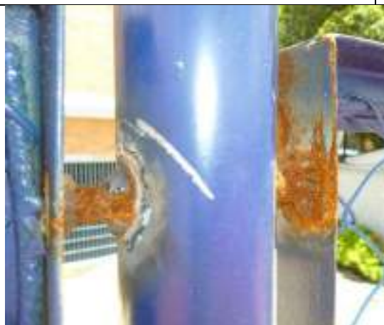
Ilustración 38: 21/05/2025 Observación de elementos oxidados y sin protección de pintura
