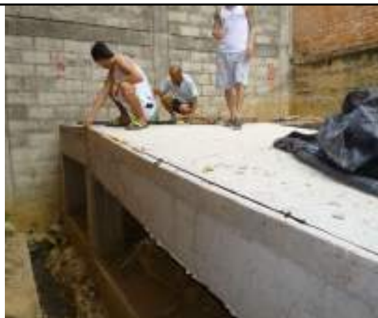
Ilustración 27: 21/05/2025 Curvatura en la pendiente de del tramo de rampa
