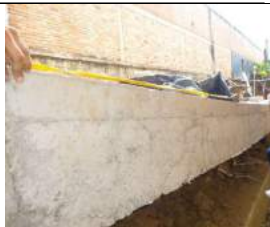
Ilustración 28: 21/05/2025 Curvatura en la pendiente de del tramo de rampa
