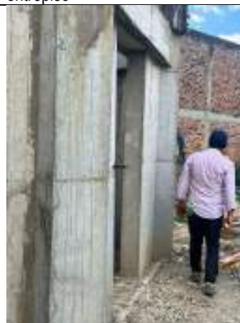
Ilustración 14: 21/05/2025 Muro sin plomo, inclinados
