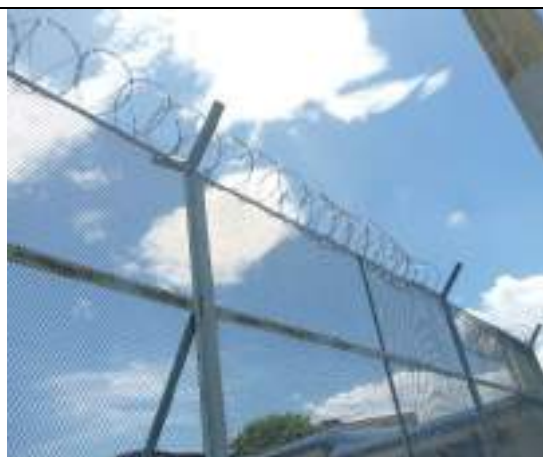
Ilustración 29: 21/05/2025 Instalación de concertina sobre malla
