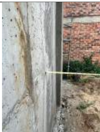
Ilustración 13: 21/05/2025 Barriga en cinco muros pantalla
