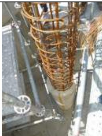
Ilustración 3: 21/05/2025 Verificación dimensiones elementos estructurales
