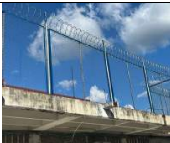
Ilustración 39: 21/05/2025 Elementos galvanizados sin pintura wash primer
